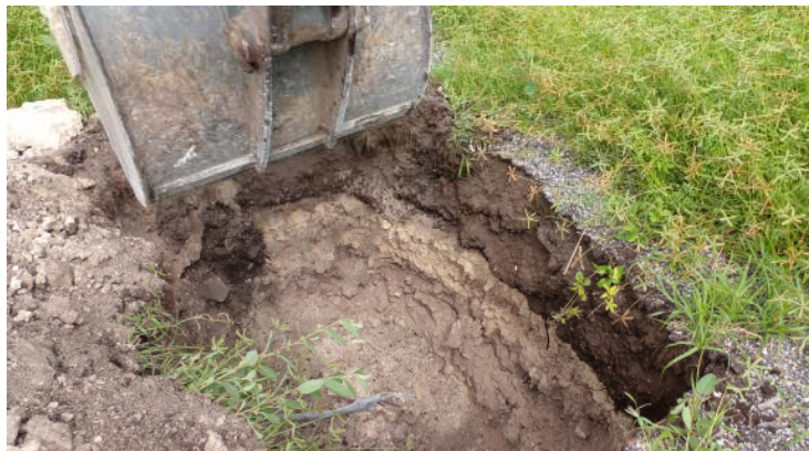
Remblais, limon et sable de couverture
