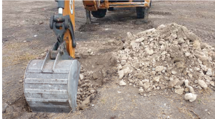
Remblais et blocs de corail de couverture
